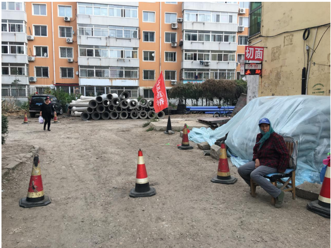
(检查施工现场)
