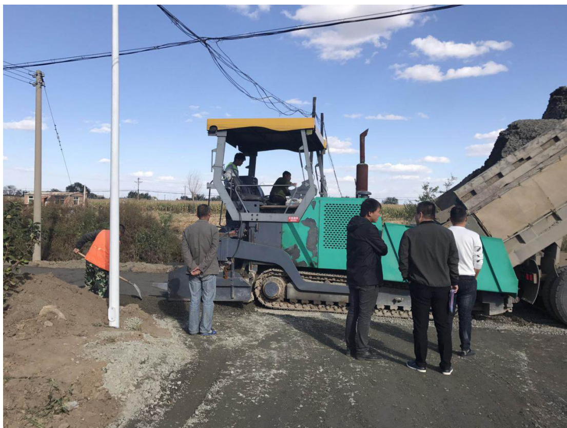
（检查施工现场）
