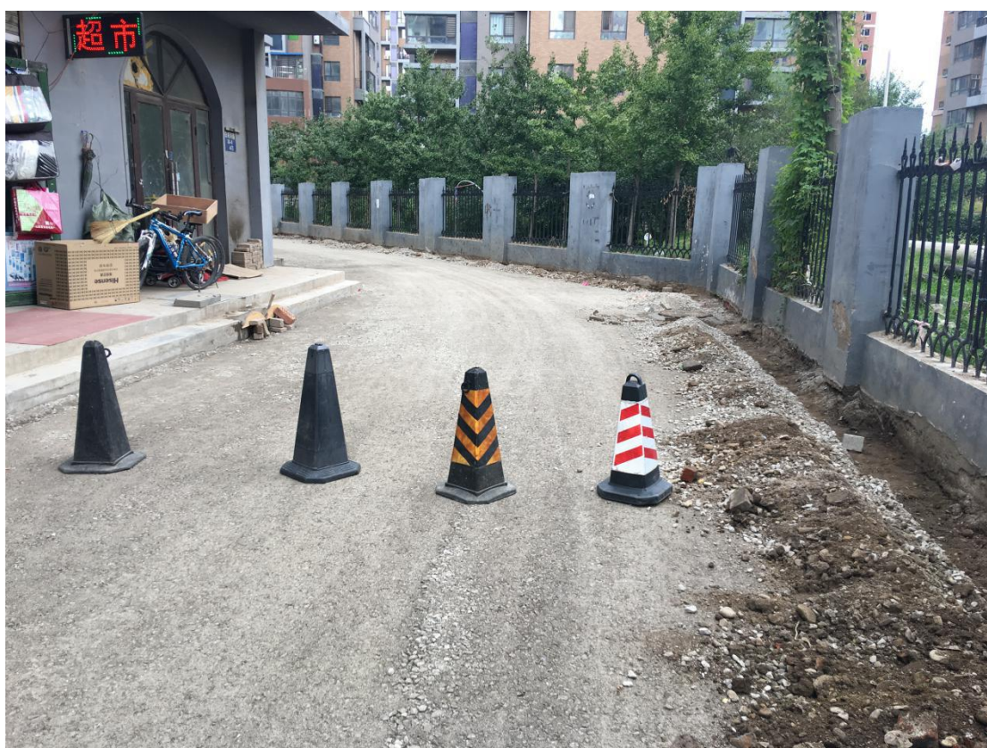
(施工现场安全锥)
