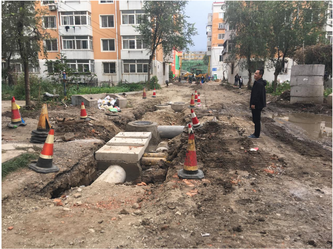
(检查施工现场)
