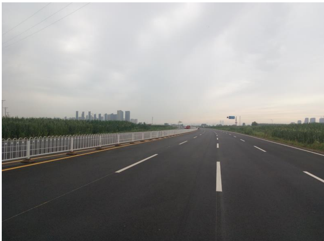
（通武线完工照片）
