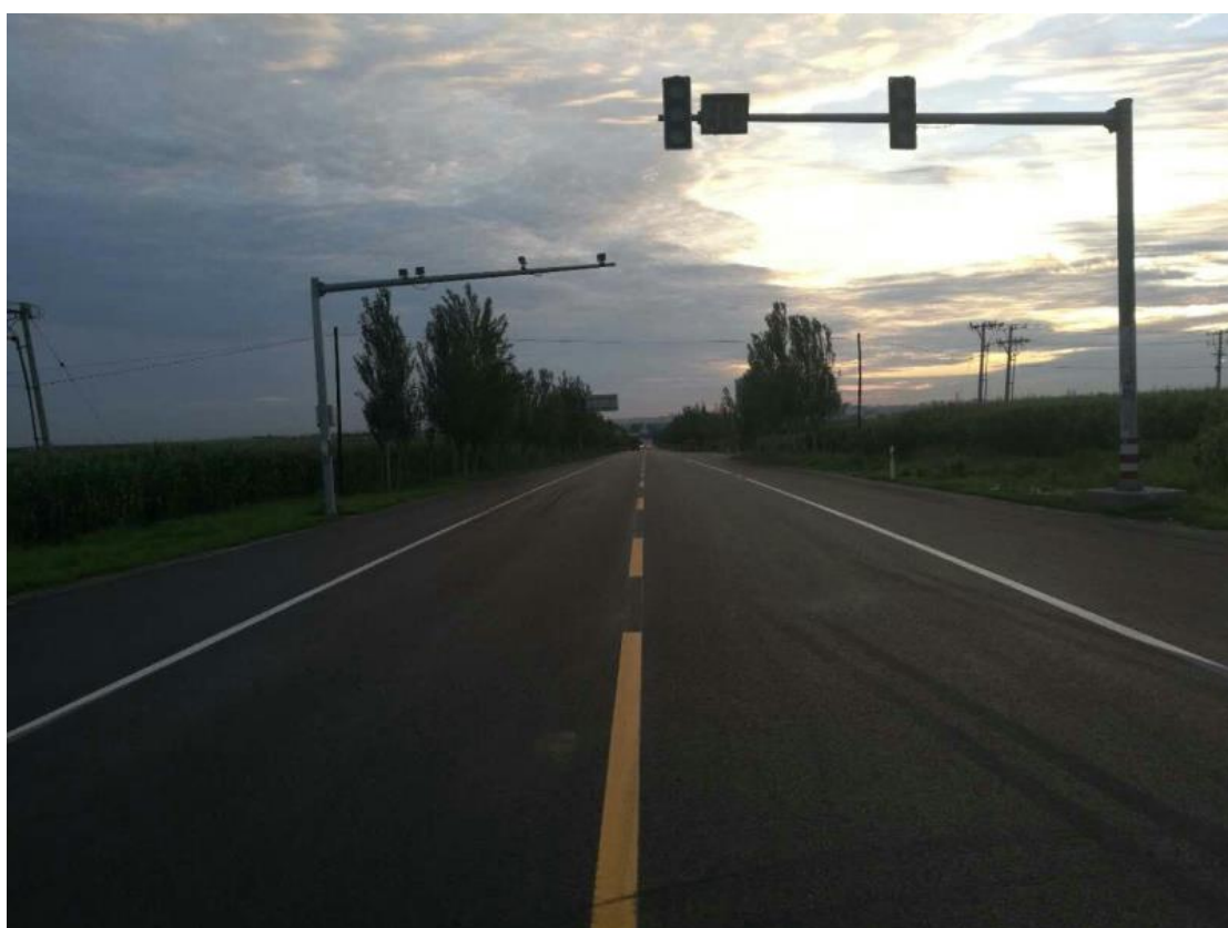
（通武线完工照片）
