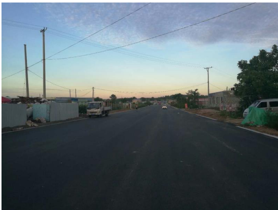
（通武线完工照片）
