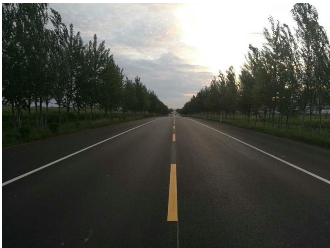
（通武线完工照片）
